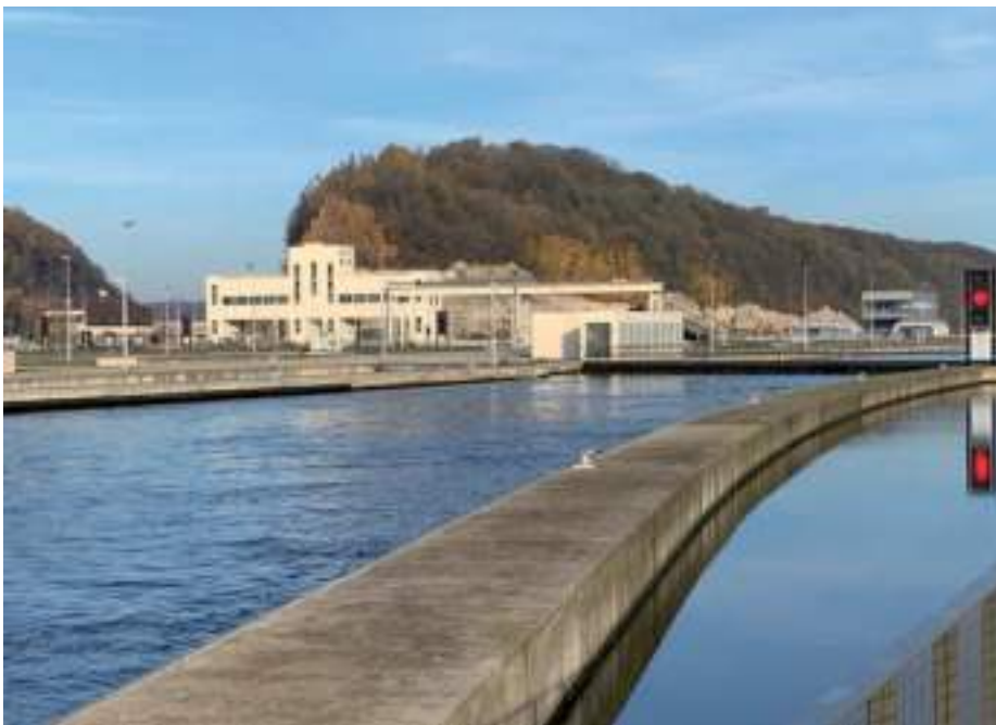
Figure 3 The lock at Ternaaien.
