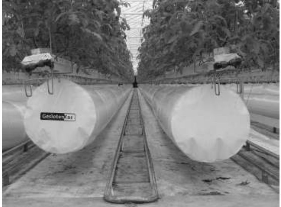
Een inktij in een GeslotenKas® waarin tomatenplanten groeien in een goot op substraat. Daaronder lopen de luchtslangen die dienen om het kasklimaat te conditioneren. In de wanden van de slangen zitten gaten waardoor koude of warme lucht de kas wordt ingeblazen. Aan het begin van de slang (in de achtergrond op de foto) staan kasten met ventilatoren die de lucht in de slang blazen.
