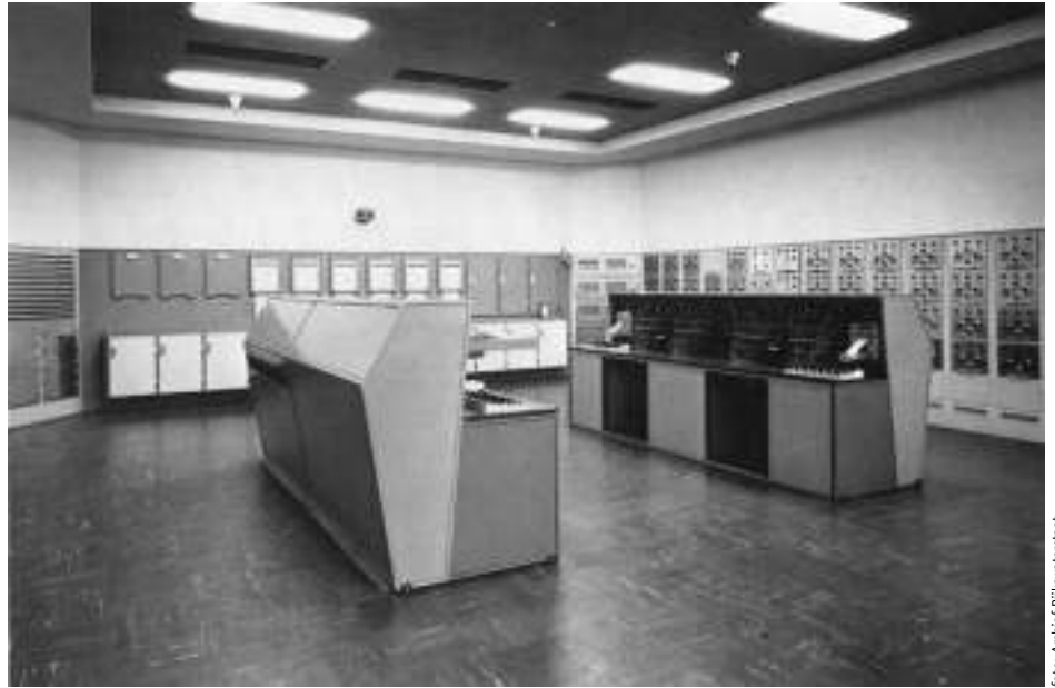
De DELTAR, de analoge rekenautomaat voor de Deltawerken.
