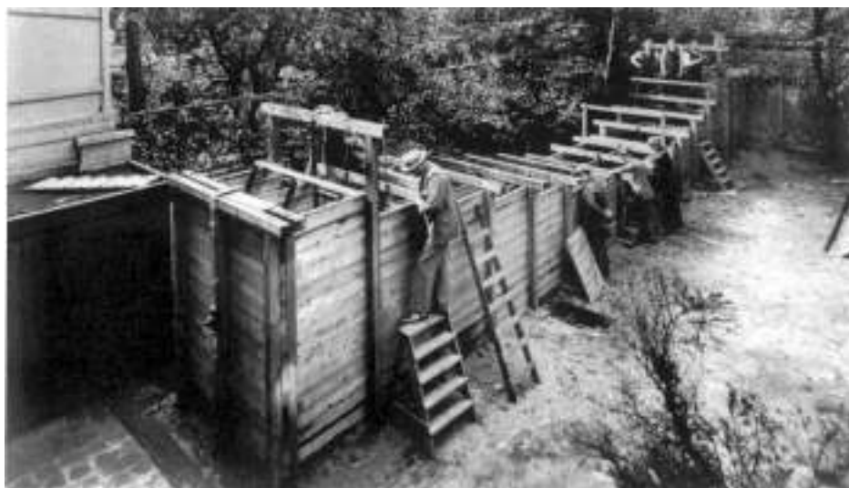
Een zeer vroege voorloper van het klapclub-onderzoek. Rijkswaterstaat bouwde in 1920 in de tuin van een van haar Haagse gebouwen een modelgoot om de golfploop te meten.
