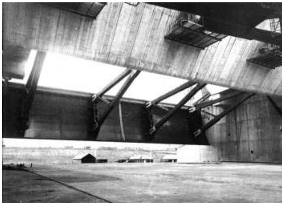
De Haringvlietsluizen in aanbouw met de nabla-ligger in beton.
